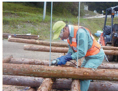
支柱のカット
